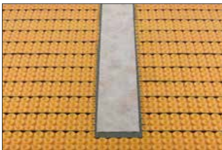
Uszczelnienie styków za pomocą Schlüter®-KERDI-KEBA
